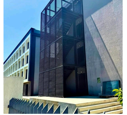
12 İZMİR VALİLİK BİNASI YANGIN MERDİVENİ VE METAL CEPHE · İZMİR
